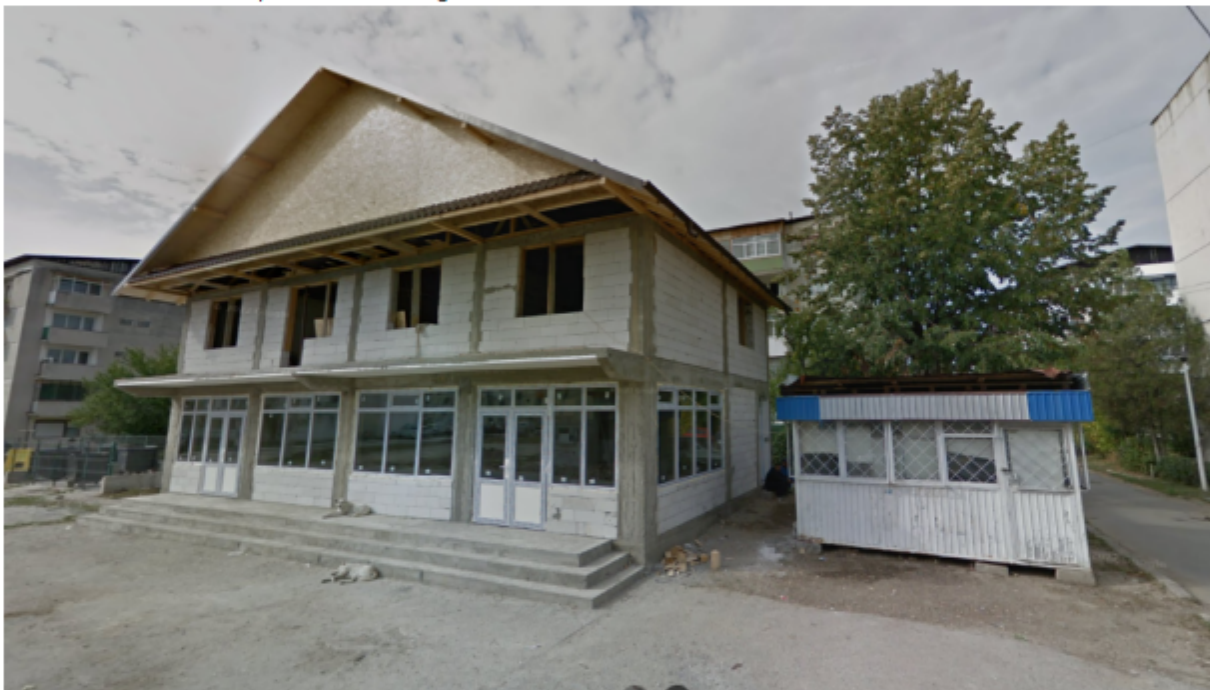
Intervenții noi- șantier
