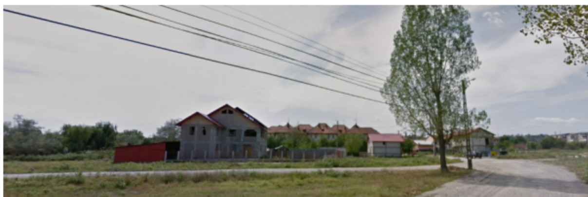
Intervenții noi- șantier, zona rezidentiala
