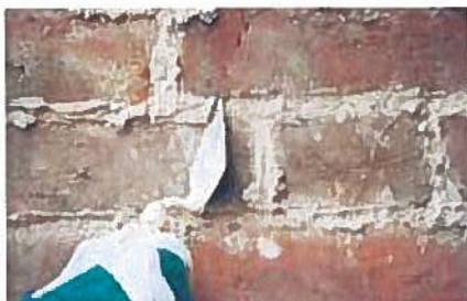
Fig.4.8 – Răzuirea marginilor elementelor zidite pentru îndepărtarea surplusului de mortar refulat.
