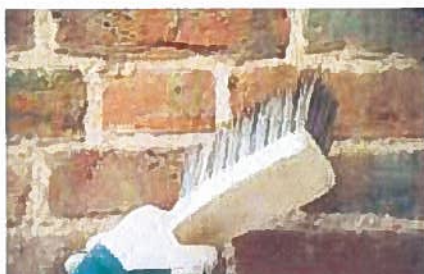
Fig.4.9 – Finisarea zidăriei prin periere diagonală.
