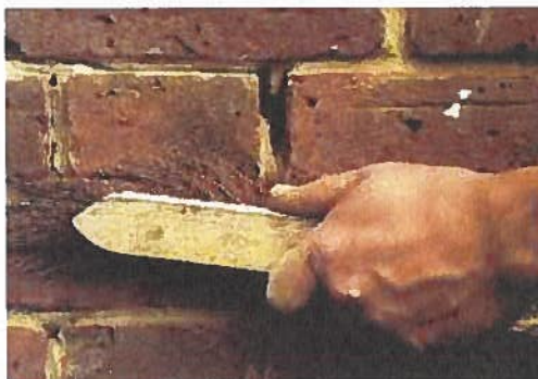
Fig.4.6 – Curățarea rosturilor deschise ale zidăriei
