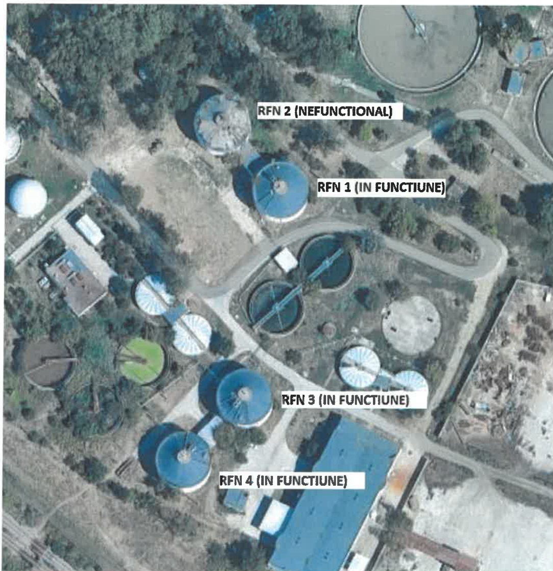
Figura 5 - Vedere de ansamblu Rezervoare pentru fermentarea anaeroba a namolului
