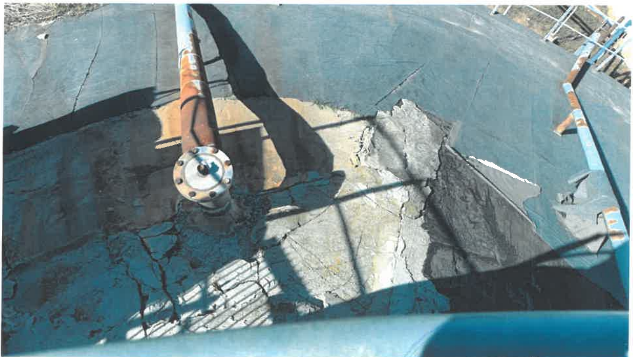
Figura 15. Vedere cupola RFN 3
