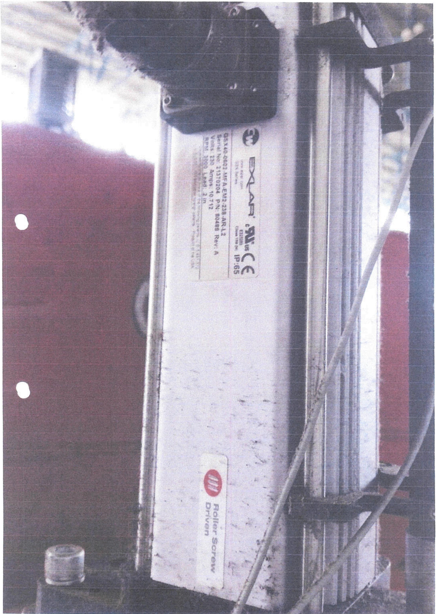
Servomotor EXLAR GSX40 - RE+1 TA3,TA4 di CTE Burendi, sud
