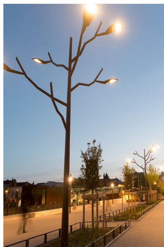
Corp de iluminat ornamental - confecție metalică, confecționat din lemn și vopsea cu 5 corpuri de iluminat stradale KYRO+1 SR/075 3105293 36W, 4799lm, 133 lm/W, 3000°K
