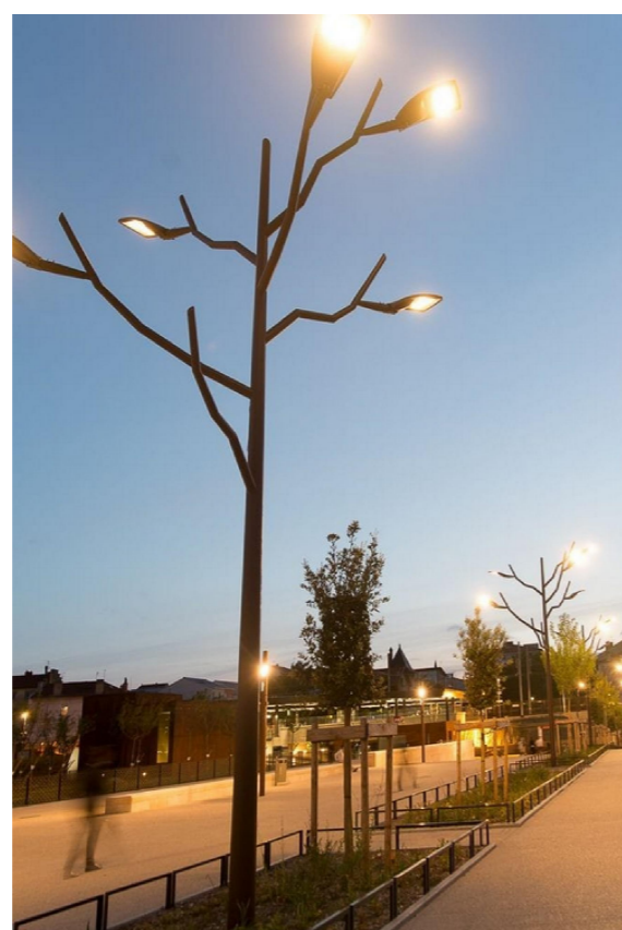
Corp de iluminat ornamental - confectionat din teava otel vopnita cu 5 corpuri de iluminat stradale KYRO+1 SR/075 3105293 36W, 4799lm, 133 lm/W, 3000°K
