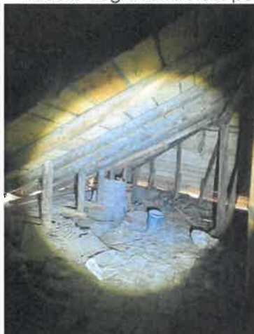
Foto 04 – Vedere sarpanta din lemn.
