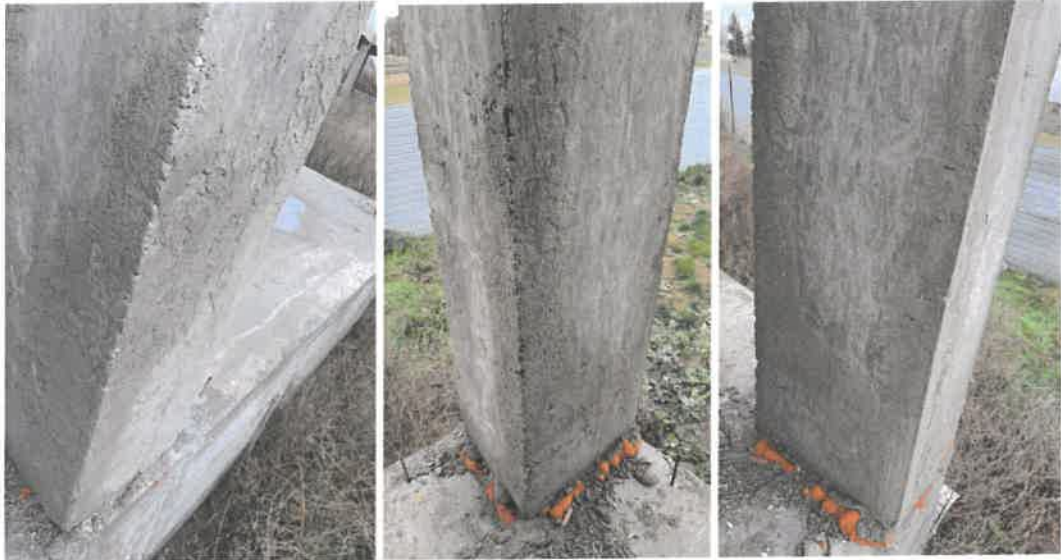
Img.4. – lucrări de finisare în vederea corectării lucrărilor de turnare
