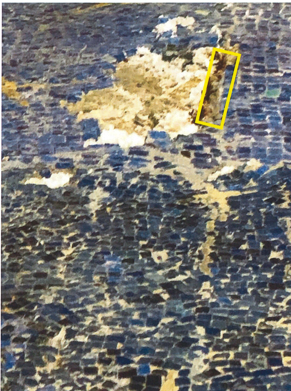
Lacună de dimensiuni mai ample creată în jurul agrafelor metalice ruginite prin dislocarea întregului strat de suport al mozaicului.
