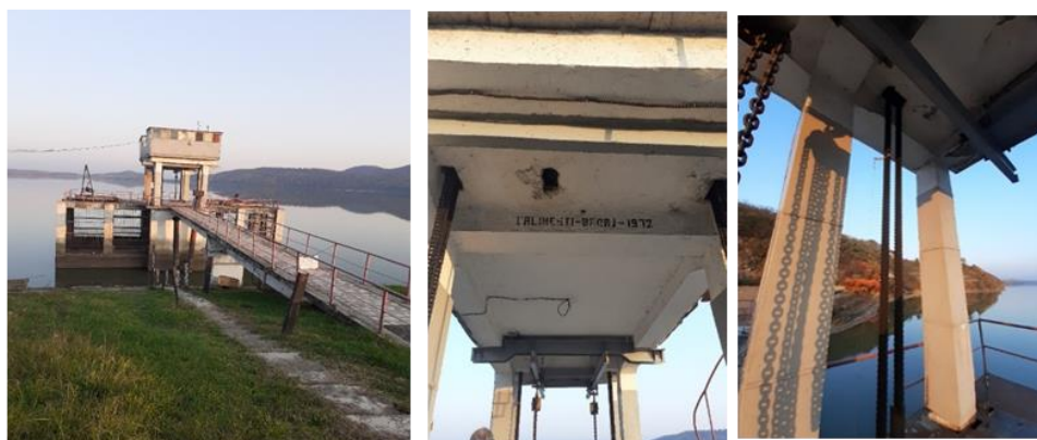
Foto 10. Baraj Călinești-Oaș. Turn deversant – Vane plane 3,00 x 2,80 mp
