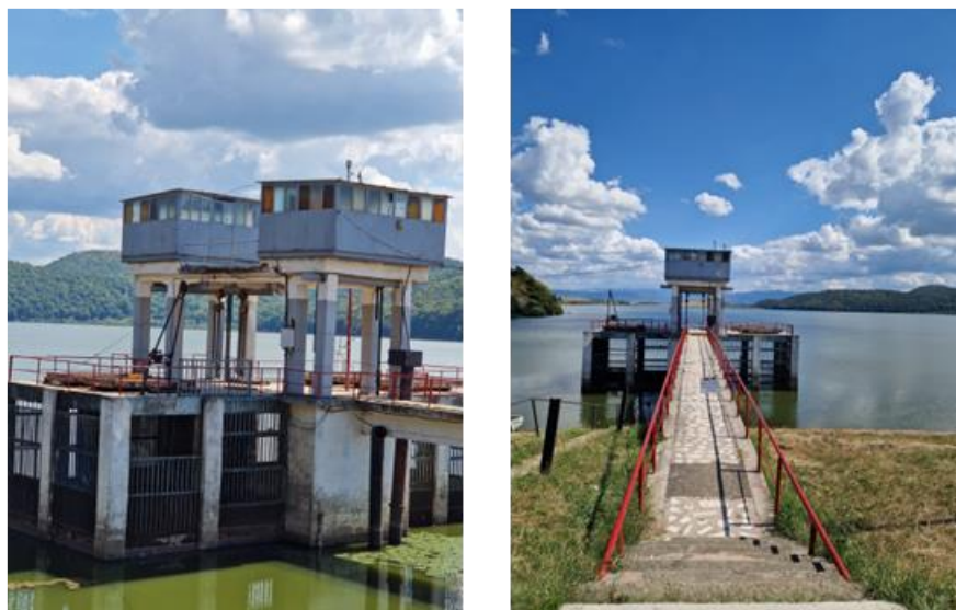
Foto 3. Turnul de priza si pasarela de acces
