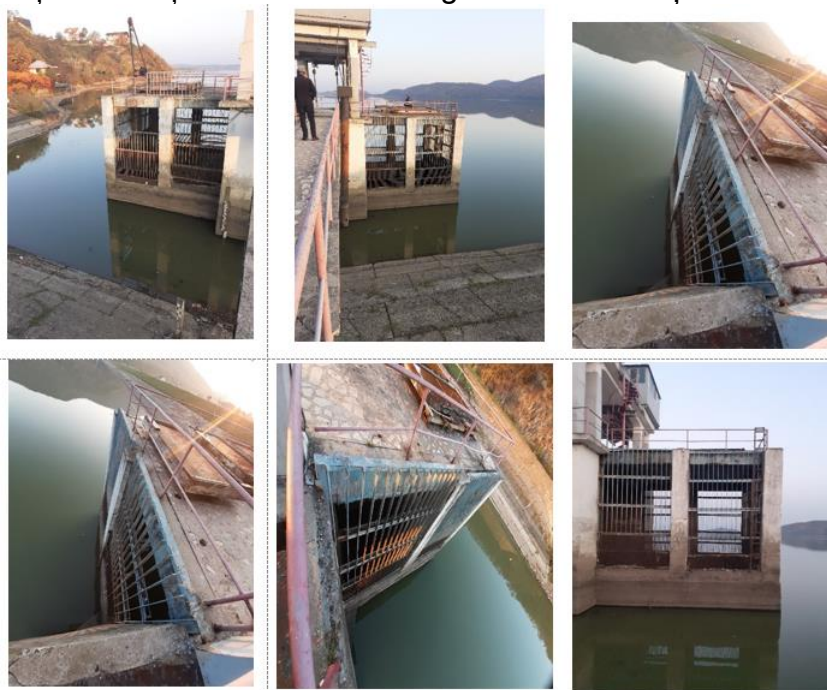
Foto 12 Baraj Călinești-Oaș. Grătare ferestre turn deversant
