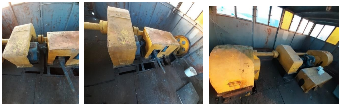
Foto11. Baraj Călinești-Oaș. Turn deversant – Cămine mecanisme acționare VP amonte și aval 3,00 x 2,80 mp
