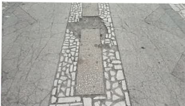
Zona pietonală - pardoseală
