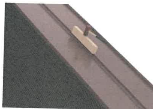
fig.16 Clipsarea pe toată lungimea panoului înainte de fixarea în șuruburi
