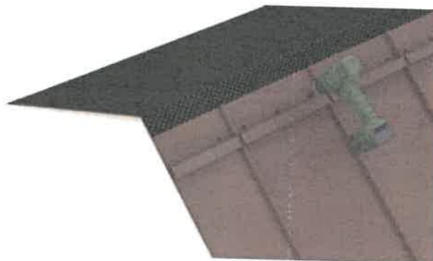
fig.41 Montajul profilului perforat de agățare
