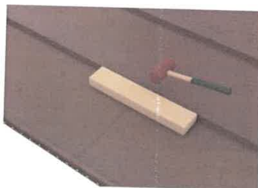
fig.39 Clipsarea și presarea definitivă cu ajutorul bucății de lemn și a ciocanului de plastic
