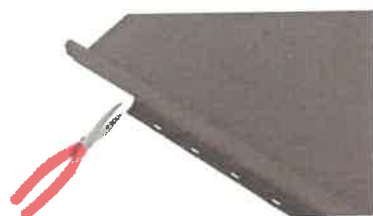
fig.32 Decupajul panoului de jos, deja montat
