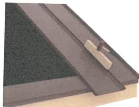
fig.14 Suprapunerea panourilor înainte de clipsare
