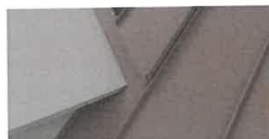
fig.59 Detaliu montaj dolie în zona de terminație.
