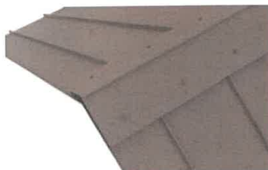
fig.48 Exemplu coamă montată
