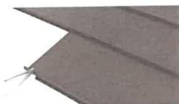
fig.34. Strângerea zonei decupate cu cleștele pentru o îmbinare mai facilă a panourilor
