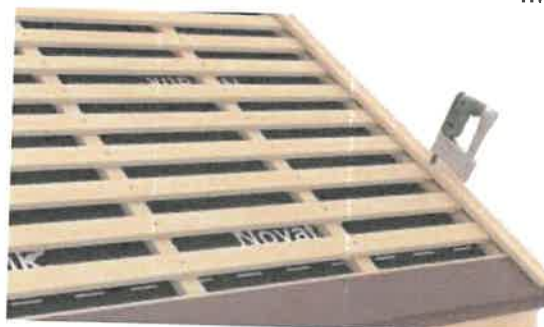
Fig.5. Montajul șipcii de lemn în zona pazei
