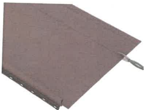
fig.49 Trasarea și tăierea panoului pe lungime
