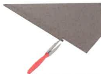
fig.33 Decupajul panoului care urmează să fie montat
