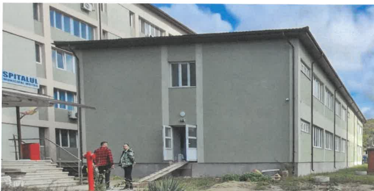
FOTO 1 – Extindere Propusa Corp C1
