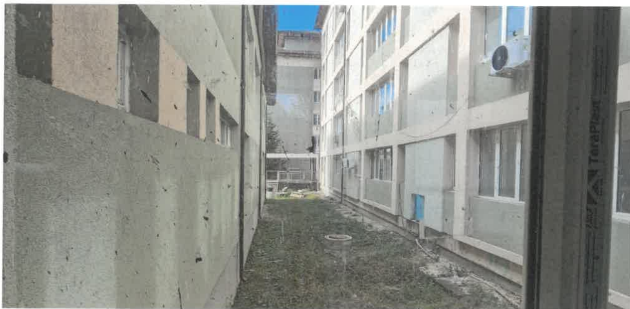
FOTO 3 - Zona dintre Corpul C1 si Extinderea Corpului C1
