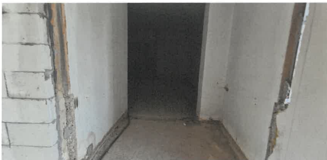
FOTO 5 - Aces din Extindere in Corpul C1
