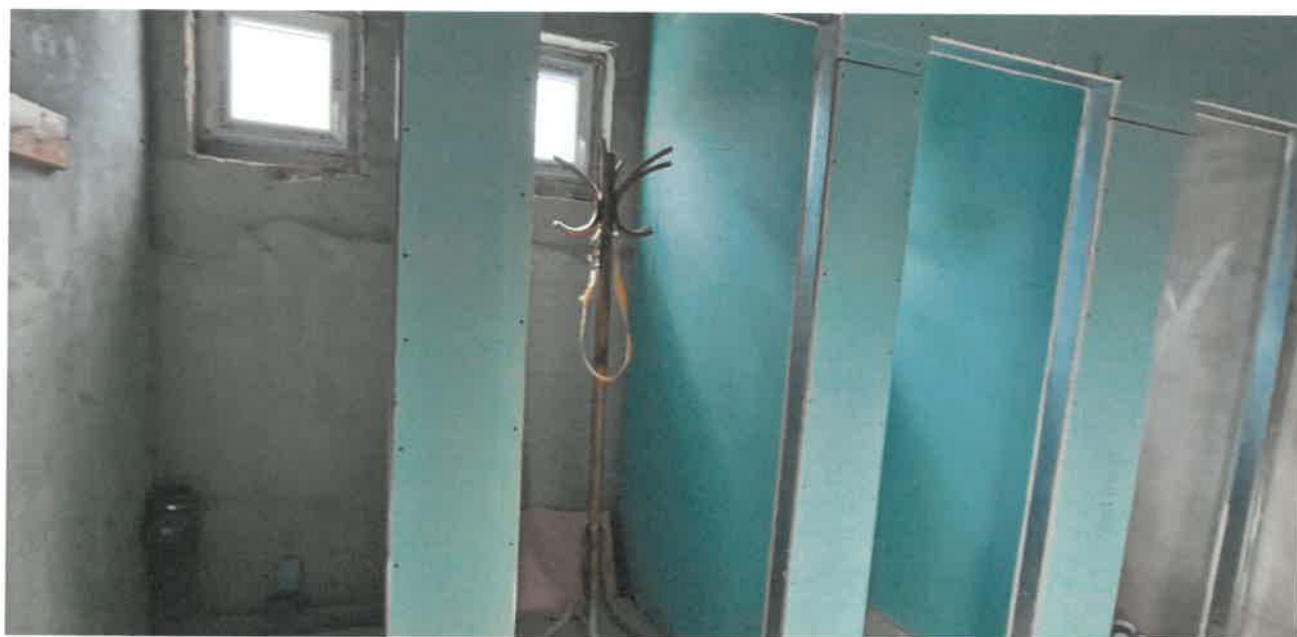
FOTO 7 - Imagini interior - Copartimentari interioare - Extindere Corp C1
