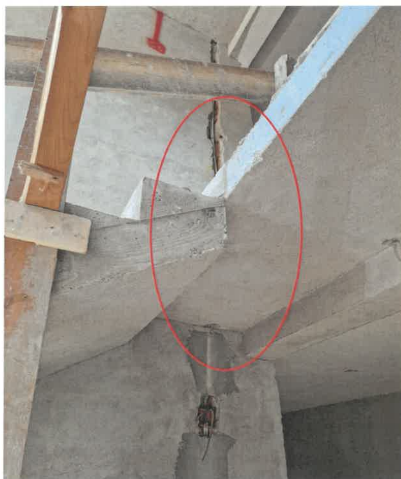
FOTO 6 - Neconformitate la scarile de acces interioare de la Extinderea Corpului C1
