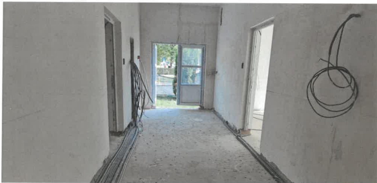
FOTO 9 - Imagini interior – Finisaje interioare partiale – Extindere Corp C1
