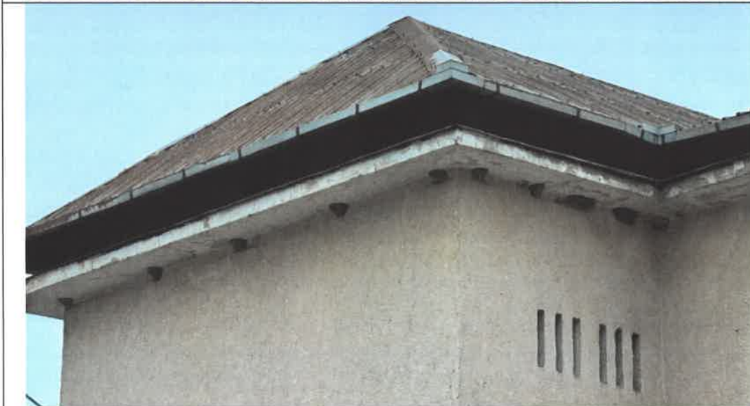
Foto 5. Învelitoare degradată;
