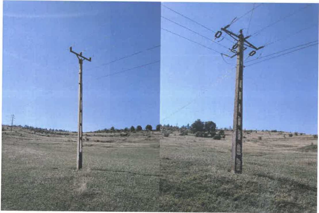
Fig. 7 – stâlpul 32 de tip SE10 nepotrivit pentru LEA 20kV. Se observă racordul aerian spre PT 21G
