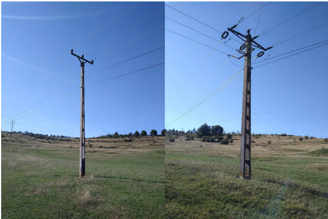
stâlpul 30 de tip SE4 nepotrivit pentru LEA 20kV
