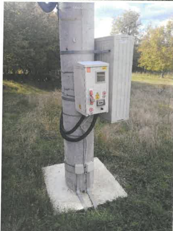
fig.1.4: Stâlpul SC10005 care alimentează FDCP8 și BMPM
