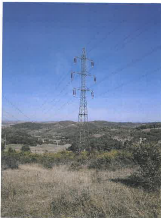
fig. 8 – stâlp SN 110 204 echipat cu izolație dublă ceramică. Stâlpul realizează supratraversarea la LEA 20kV studiată.
