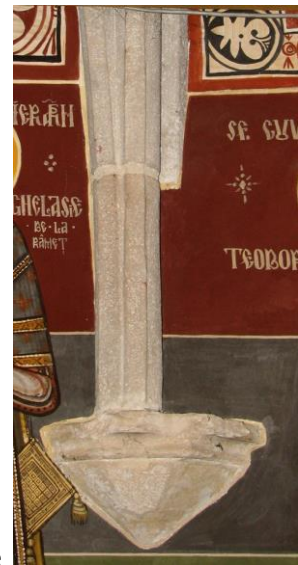
Fig. 11. a. Detaliu din actualul altar cu naștere de boltă demolată; b. Ferestre și cornișă gotică la latura vestică a altarului; c. Bolta traveii estice a naosului; d. Bolta traveii vestice din naos și cafas din lemn; e. Una din cele două console cu porniri de nervuri gotice din traveea vestică a naosului.
