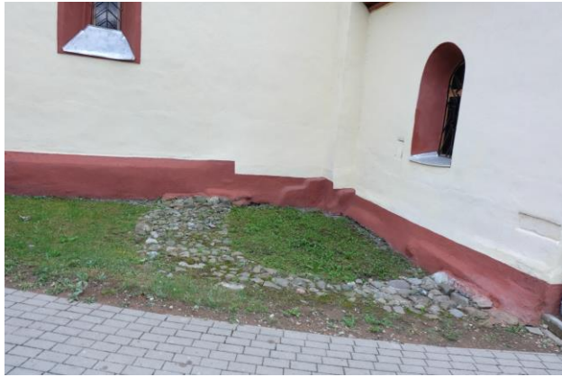
Fig. 19. a. Marcajul de la nivelul solului pentru absidiola nordică (Foto: 2020) și incoerențe de la nivelul soclului actual; b. Marcajul (rectangular!) pentru absidiola sudică și zidul estic al colateralei sudice arătând etapa medievală și cea de la 1858 (Foto: 2020).
