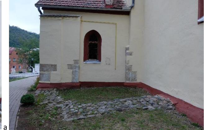
Fig. 19. a. Marcajul de la nivelul solului pentru absidiola nordică (Foto: 2020) și incoerențe de la nivelul soclului actual; b. Marcajul (rectangular!) pentru absidiola sudică și zidul estic al colateralei sudice arătând etapa medievală și cea de la 1858 (Foto: 2020).
