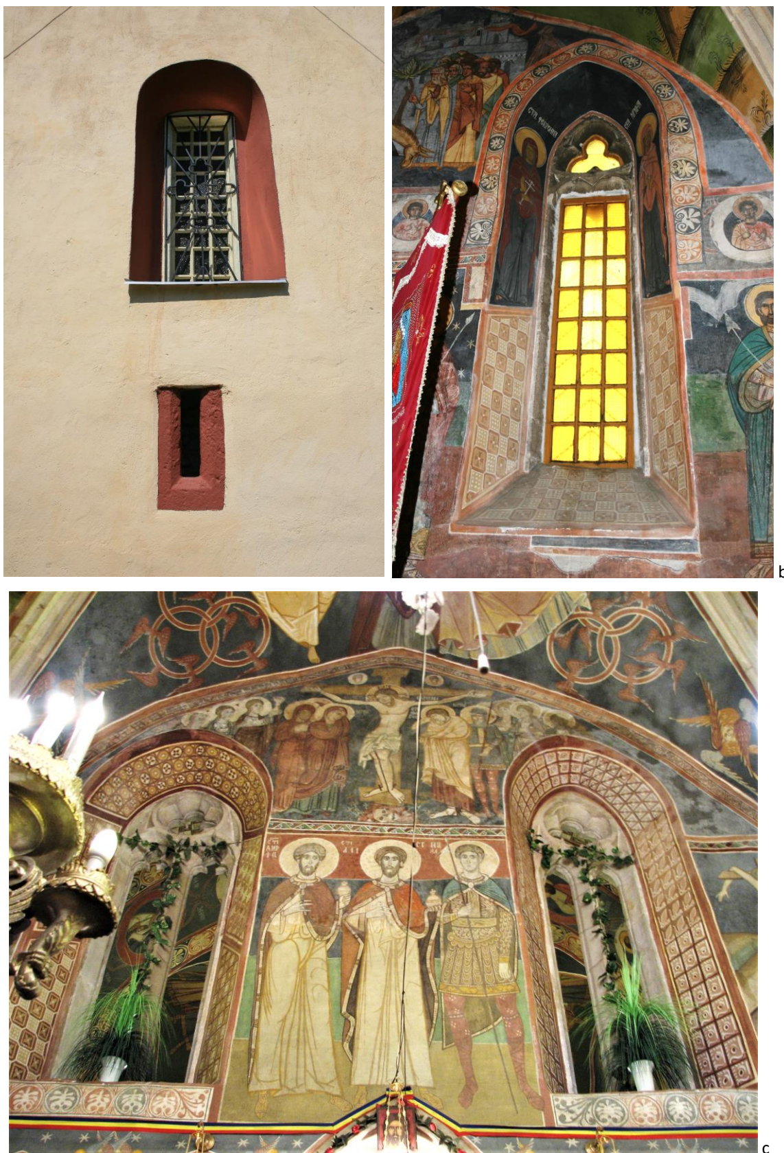
Fig. 12. a. Ferestrele laturii estice a altarului indicât două etape de construcție la altar; b. Fereastra nordică a traveii estice a naosului; c. Zidul dintre altar și naosul actual cu ferestre gotice și Răstignirea suprapunând scena cu Sf. Militari – pictură medievală restaurată post 1993.
