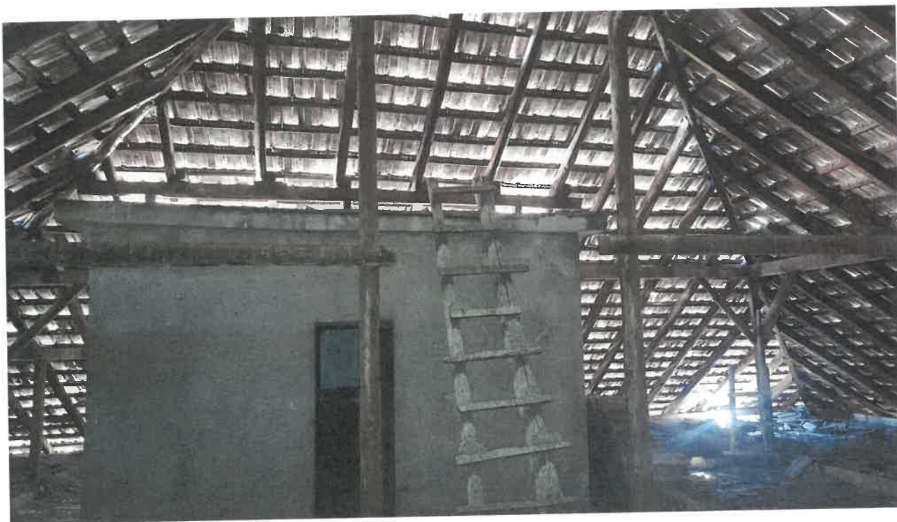
Fig. 16: Casa scării , pod
