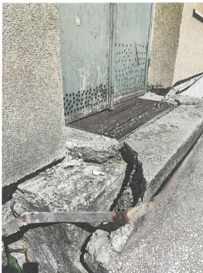
Fig. 13: Scări de acces la intrarea secundară, degradate
