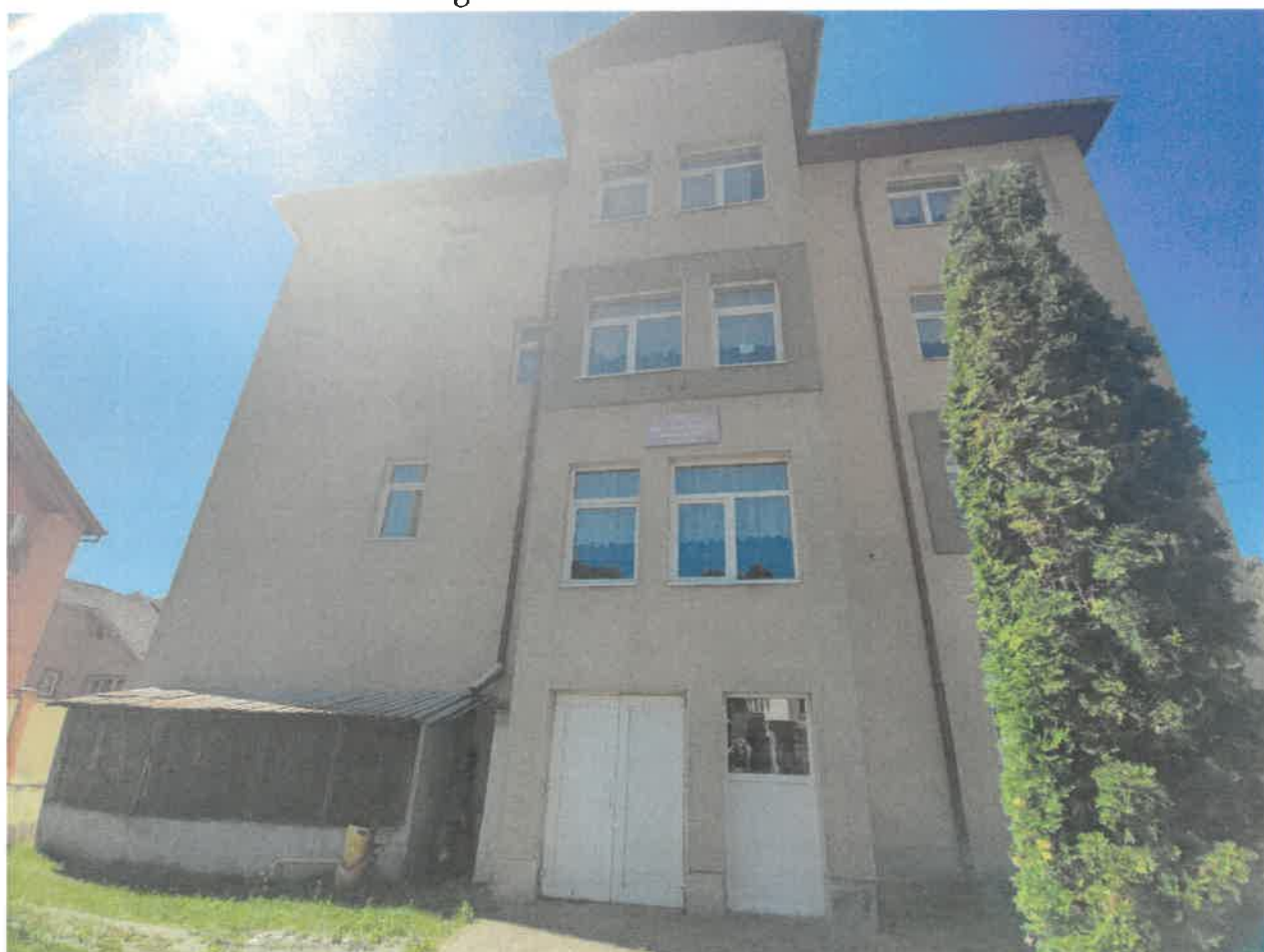
Fig. 4: Degradari datorate infiltratiilor de apa de la subsol
