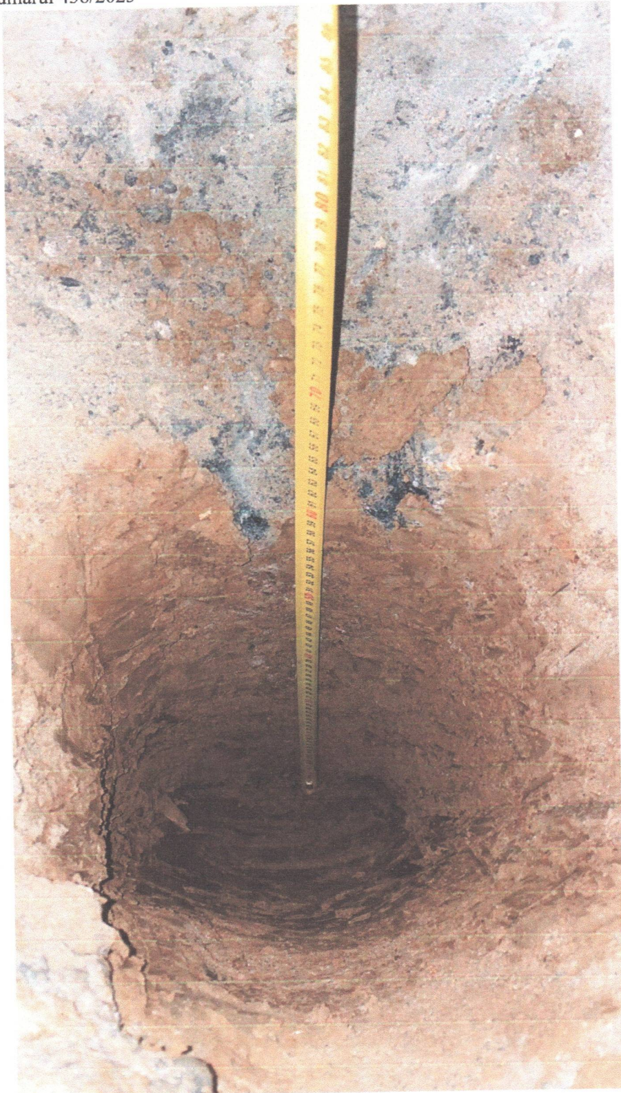
Figura 11. Dezvelire de fundatia executata la nivelul subsolului.
