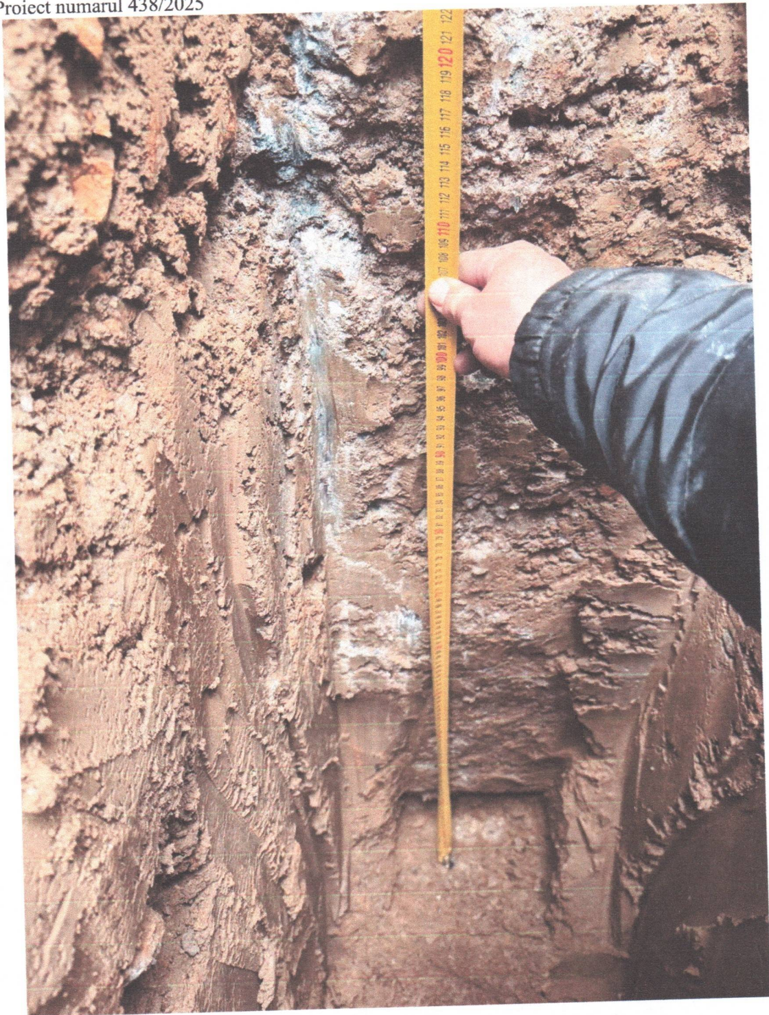
Figura 14. Dezvelire de fundatie executata la cota terenului amenajat
