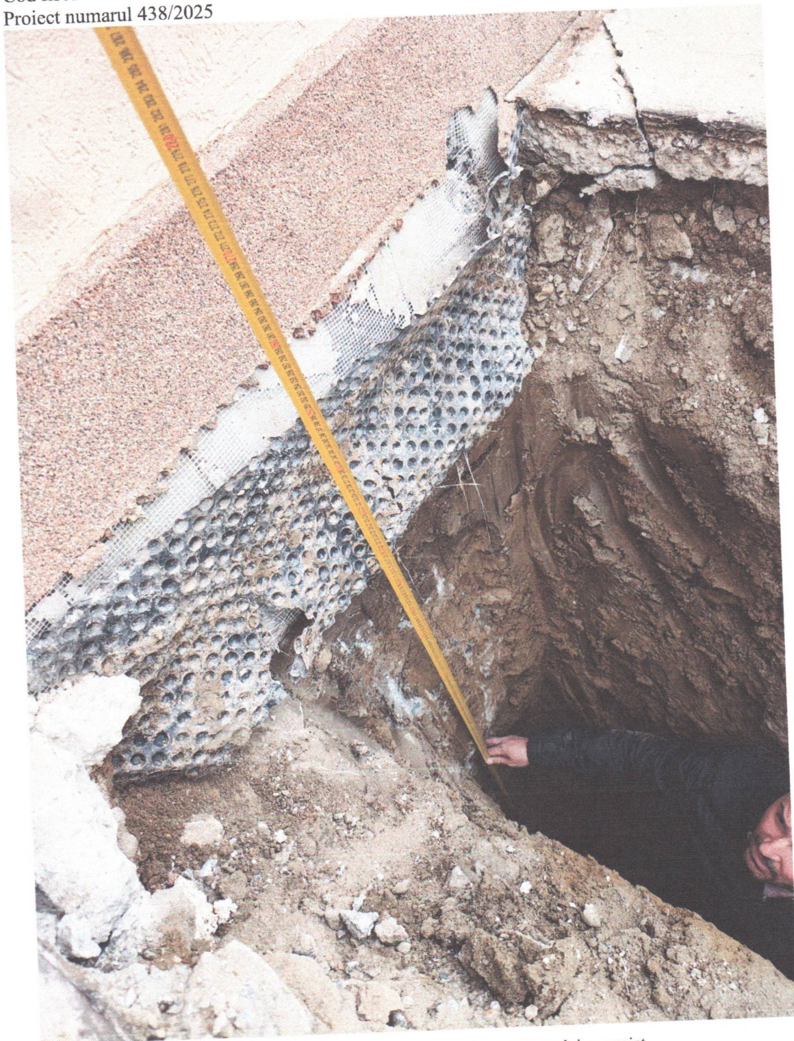
Figura 13. Dezvelire de fundație execută la cota terenului amenajat
