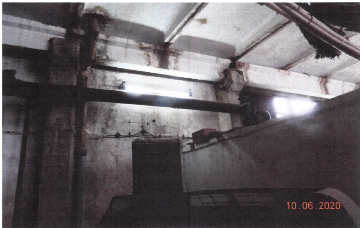
FOTO 3. PRELUAREA DEFICITARĂ A APELOR PLUVIALE PRIN INTERIORUL CLĂDIRII
