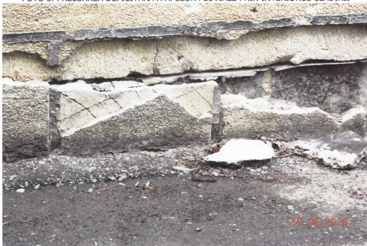
FOTO 4. TENCUIELILE SOCULUI CĂZUTE DIN CAUZA INFILTRĂRII APEI ȘI A FENOMENULUI DE GELIVITATE, FÂȘIE PREFABRICATĂ DIN BCA ARMAT FISURATĂ
