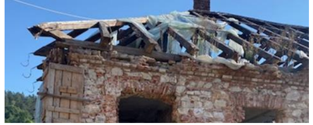
Foto nr. 6 - Șarpanta
