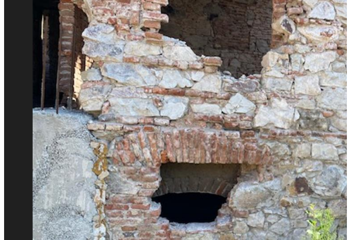
Foto nr. 2 - Sâmbure din beton armat in faza de execuție.
