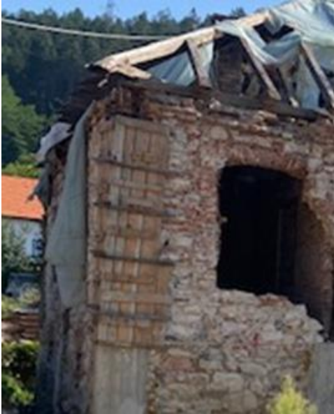
Foto nr. 1 Confinarea structurii cu elemente din beton armat
