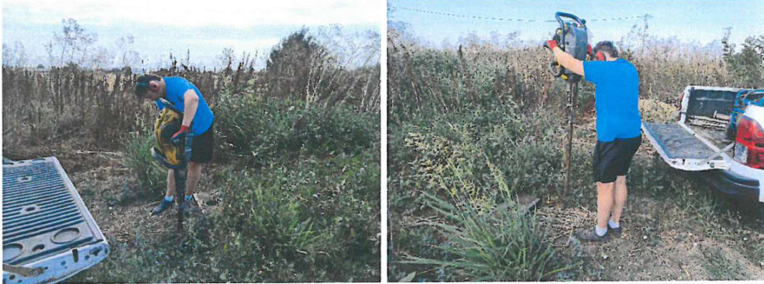
Figura 12. Realizare foraj geotehnic
