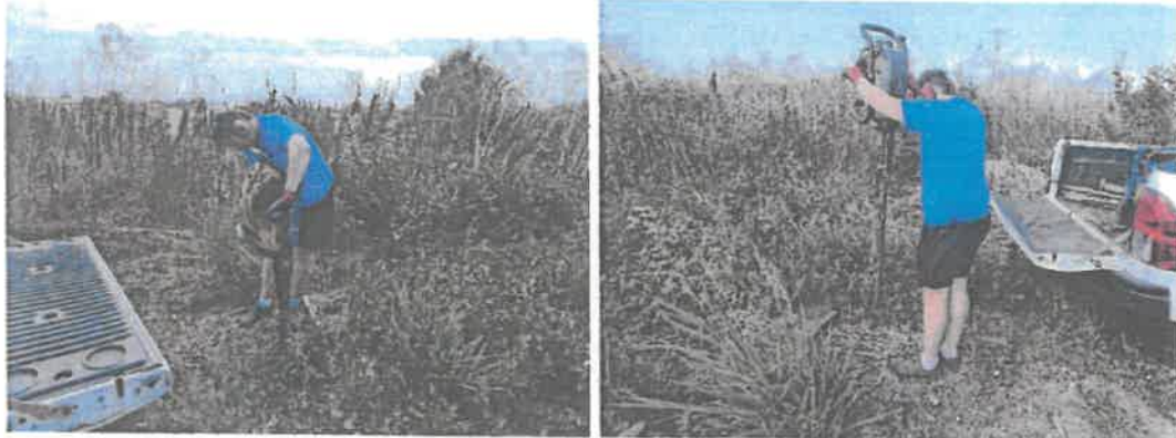
Figura 12. Realizare foraj geotehnic
