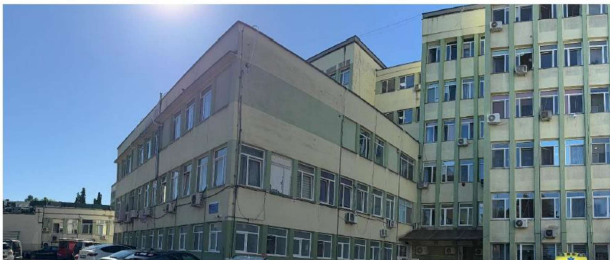
Vederi generale exterioare
