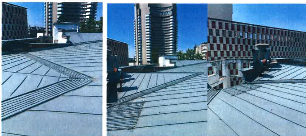
Figura 4– Acoperis cu invelitoare din tabla
