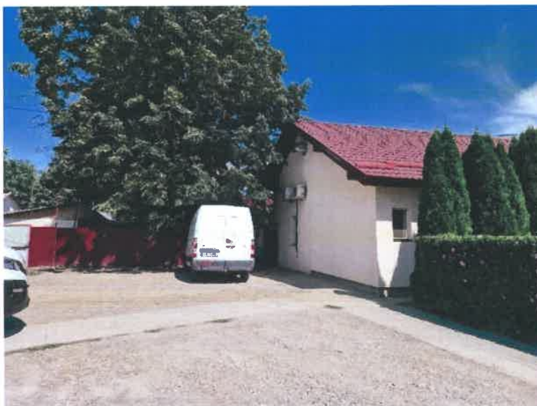
Figura 1 – Colțul clădirii către Sud
