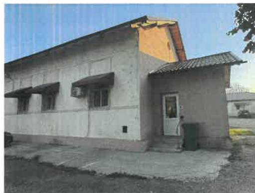
Foto 04 – Vedere trotuar local.
