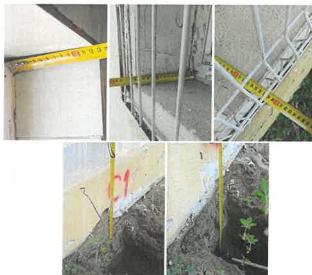
Fig.4.2. – Dezvelire Corp C1
