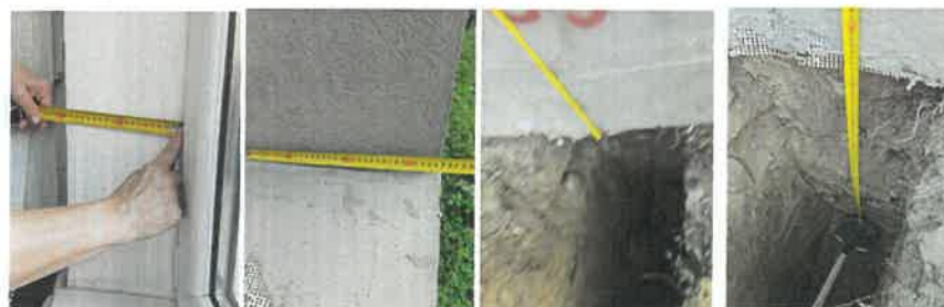
Fig.4.2. – Dezvelire Corp C3 spate
