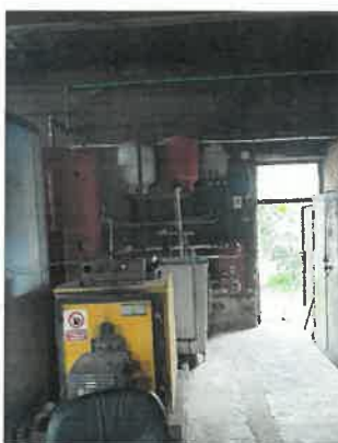
Foto 04 – Vedere de ansamblu interior.
