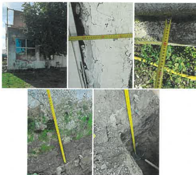
Fig.4.2. – Dezvelire Corp C4
