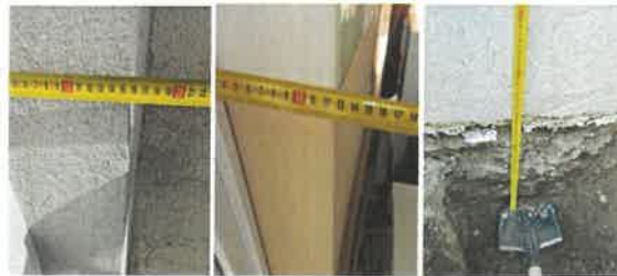
Fig.4.2. – Dezvelire Corp C25
