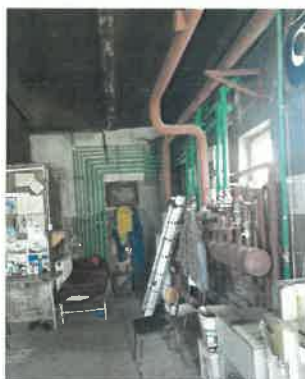
Foto 03 – Vedere de ansamblu interior.
