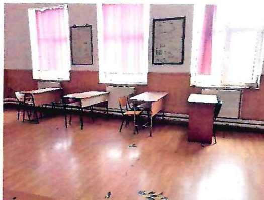
Figura 3 – Finisaje interioare – pereți și pardoseală
