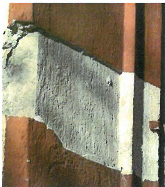
Fig.32. Test de curățire ancadrament (stânga)/ Test de curățire capac contrafort (dreapta)
