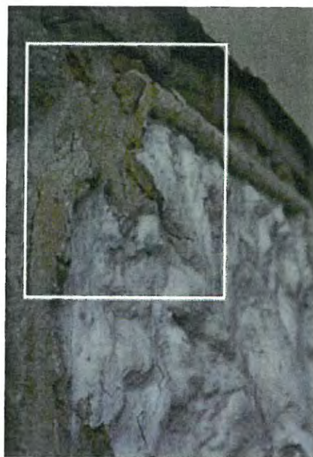
Fig. 34 a-b. Degradări provocate de acțiunea apei. Piatră funerară, latura de nord.
