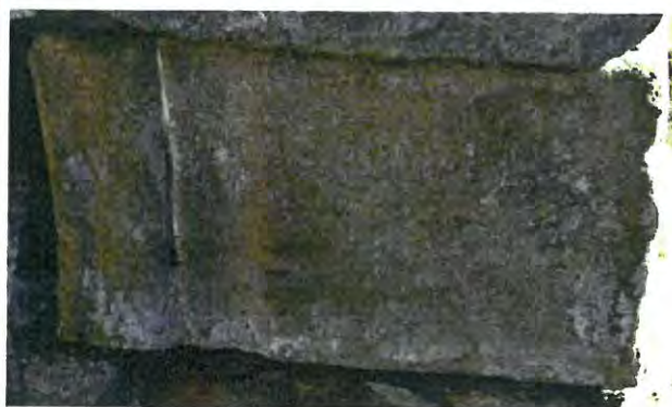
Fig. 37 (a-b). Fenomenul de dizolvare la rocile sedimentare sub acțiunea chimică a apei pluviale poluate. Piatră de colț, molon contrafort sud-vestic.
