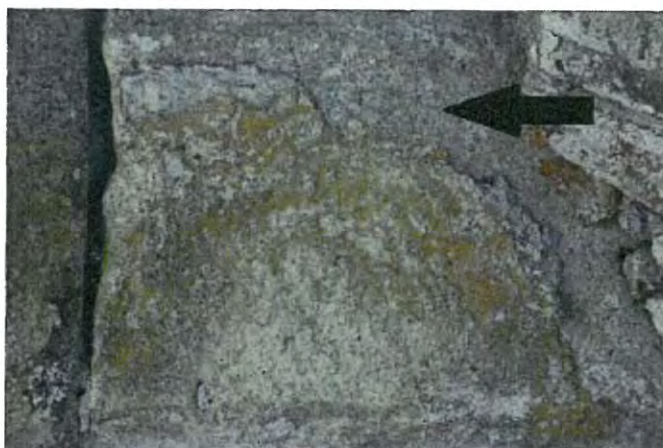
Fig. 35. Dezagregarea gresiei la nivelul soclului edificiului, cu prezența fenomenului de “solzire”, fațada de vest.
