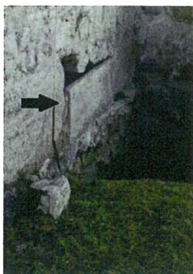
Fig.21. Piesă de soclu reutilizată în zidăria laturii nordice a absidei altarului
