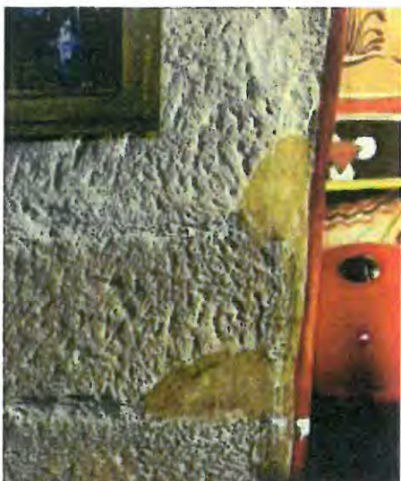
Fig. 46. Reîntregiri volumetrice și rosturi neadecvat cromatic
