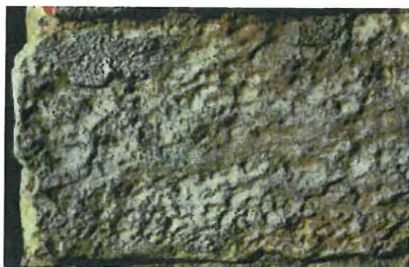
Fig. 37 (a-b). Fenomenul de dizolvare la rocile sedimentare sub acțiunea chimică a apei pluviale poluate. Piatră de colț, molon contrafort sud-vestic.
