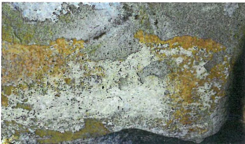
Fig.39. Crustă carbonatică (detaliu molon – soclu latura sudică)
