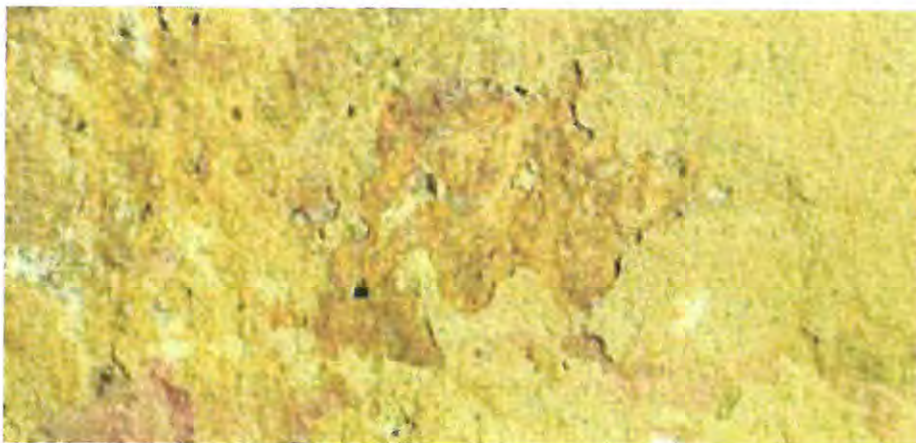
Fig. 33. Exfolieri termogene la moloane de gresie apaținând soclului, latura de sud.
