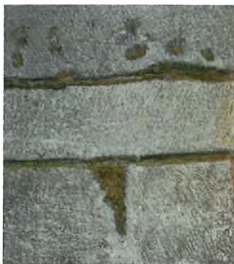
Fig. 46. Reîntregiri volumetrice și rosturi neadecvat cromatic
