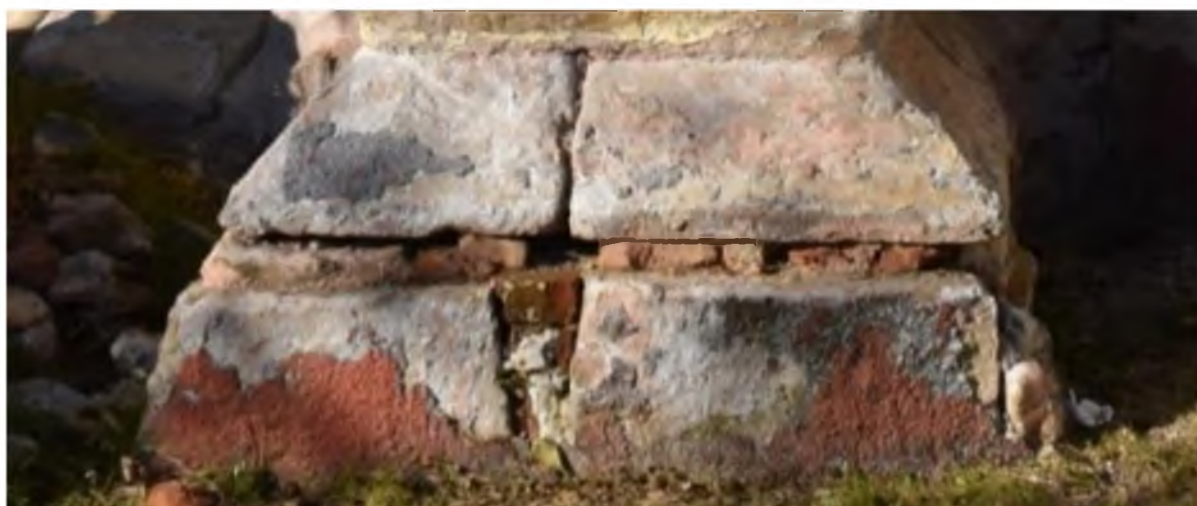
Fig. 42. Acoperiri cu mortare de ciment, contrafort- latura sudică
