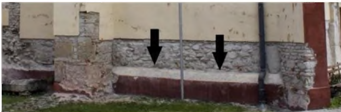
Fig. 14. Latura nord-vestică (detaliu soclu)
