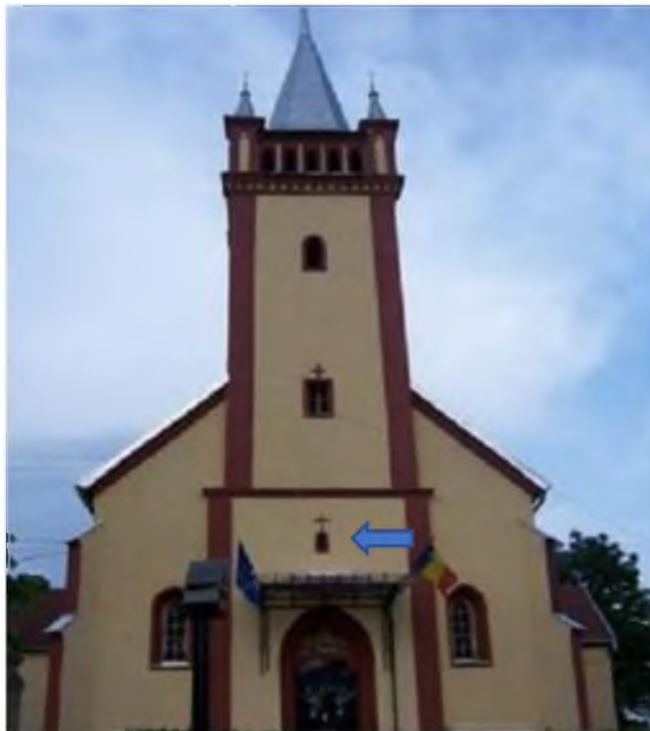
Fig.12. Ancadrament din piatră turn vest
