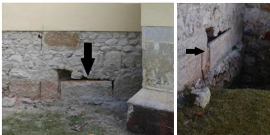
Fig.21. Piesă de soclu reutilizată în zidăria laturii nordice a absidei altarului
