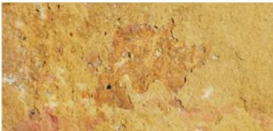
Fig. 33. Exfolieri termogene la moloane de gresie așezându-se soclului, latura de sud.
