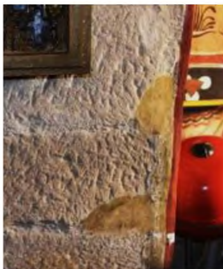
Fig. 46. Reîntregiri volumetrice și rosturi neadecvat cromatic
