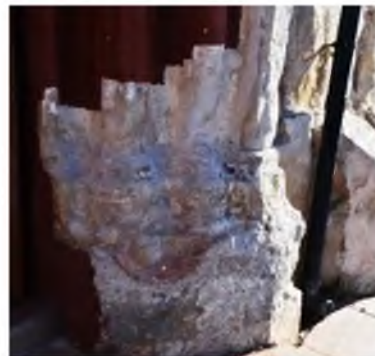
Fig. 6. Bazele montanților portalului principal
