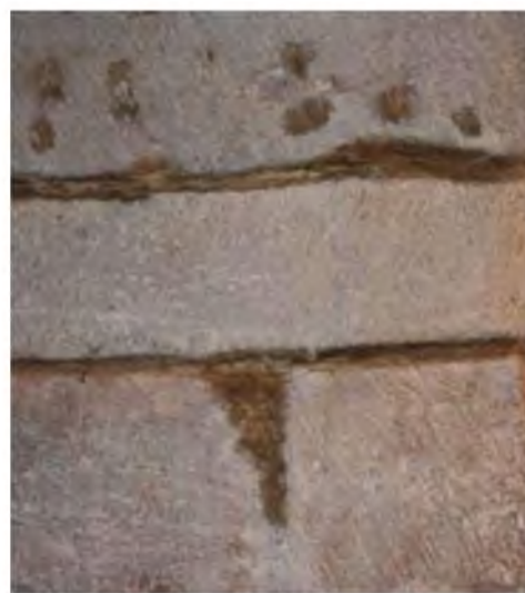
Fig. 46. Reîntregiri volumetrice și rosturi neadecvat cromatic
