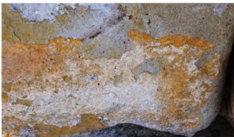
Fig.39. Crustă carbonatică (detaliu molon – soclu latura sudică)
