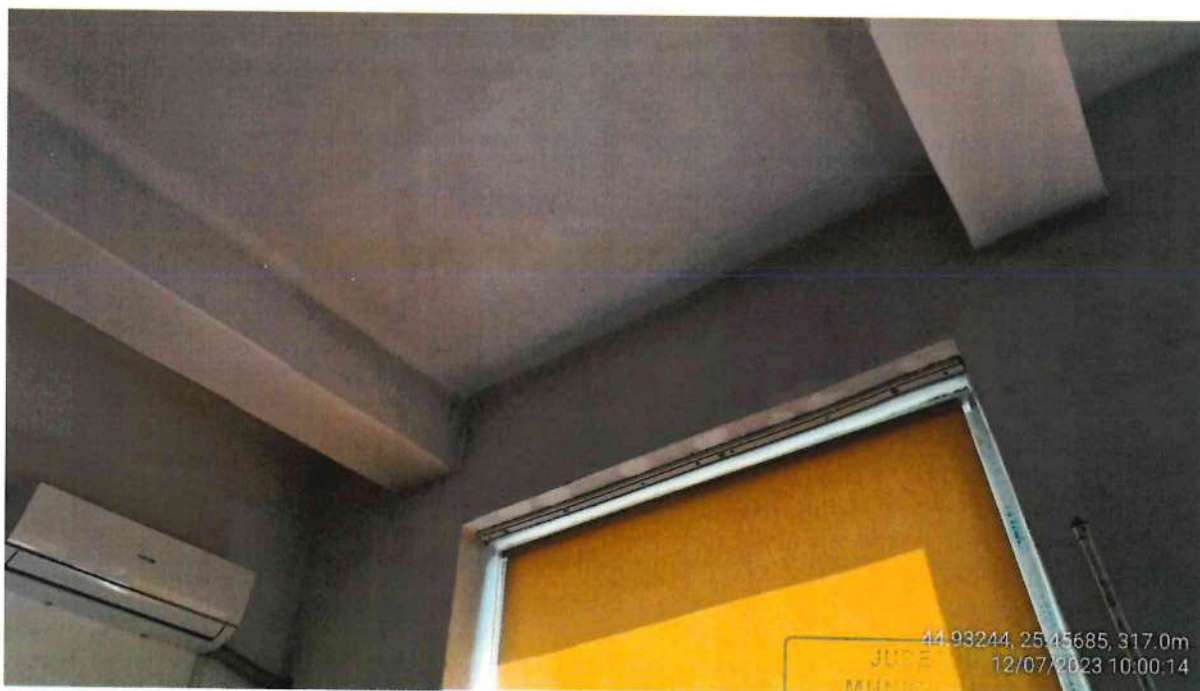
Figura 8 – Punte termică în dreptul planșeului și grinzilor BA, cu prezență puncte negre
